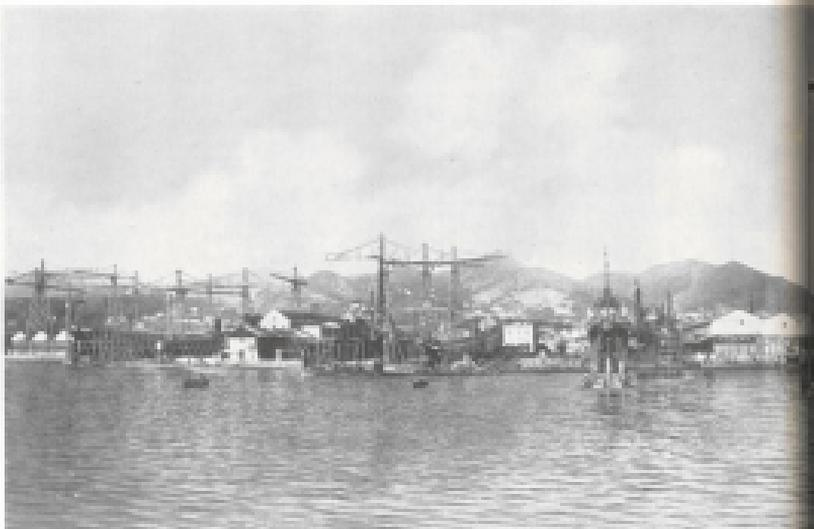
Una vecchia fotografia del cantiere di Sestri prima della costruzione della diga di protezione. C'erano ancora le gru a fondazione.
